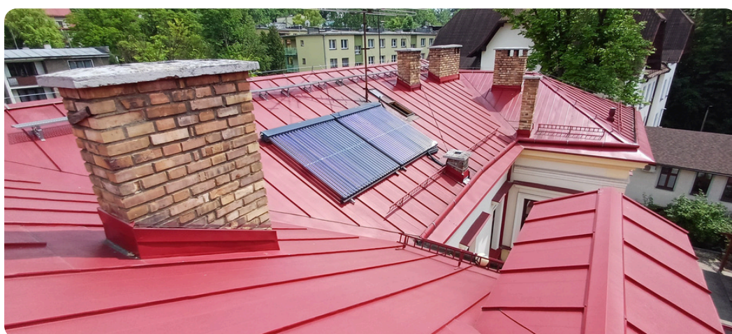
Fragmenty wyremontowanego dachu
