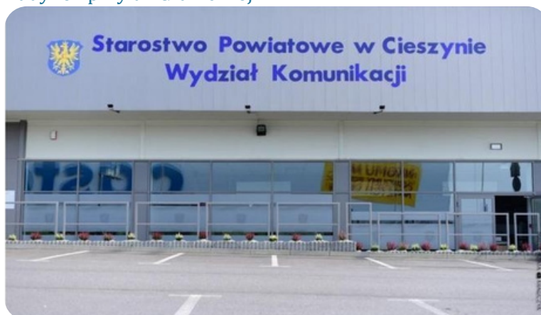
Budynek przy ul. Granicznej
