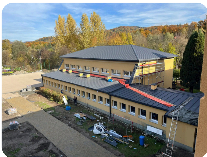
W trakcie prac termomodernizacyjnych
