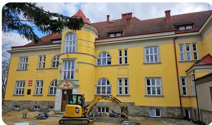
Sprzęt budowlany przed budynkiem szkoły
