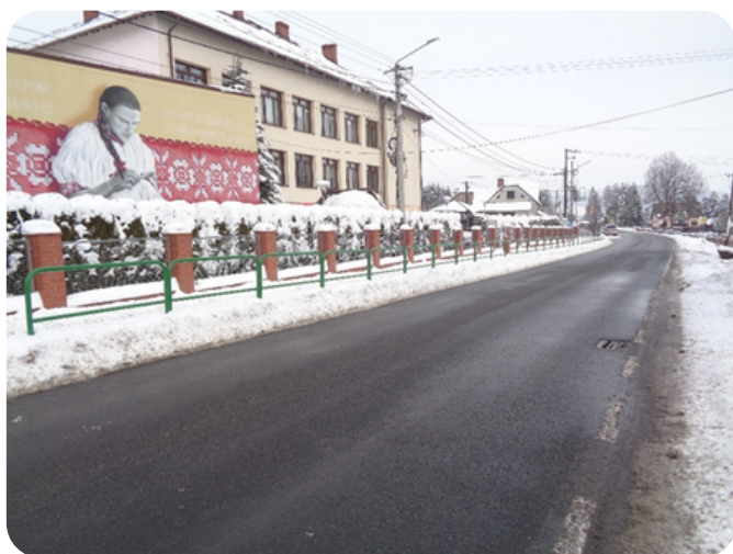
Przedmiotowa droga powiatowa 2644S przed odbiorem końcowym robót
