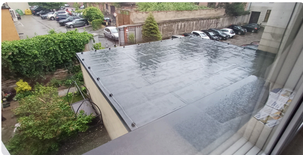
Dach po naprawie
