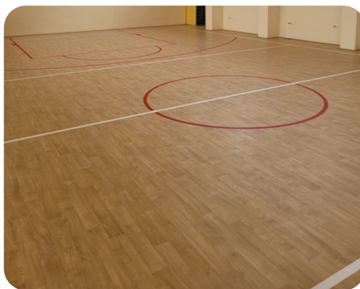
Fragment wyremontowanej nawierzchni sali sportowej
