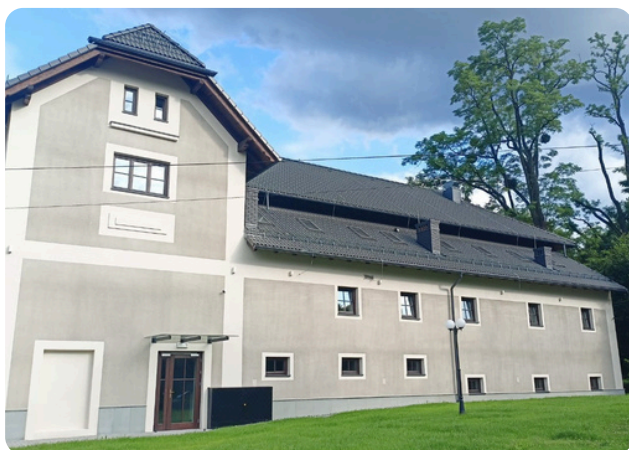
Spichlerz - tył budynku
