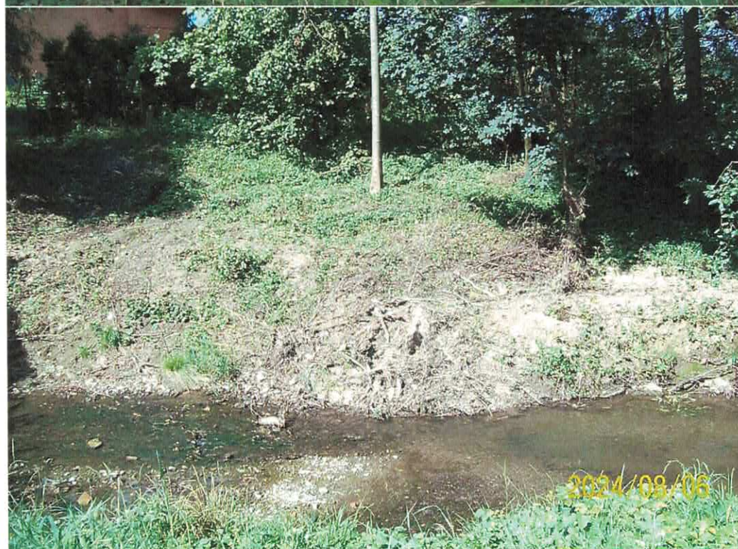
Uprzątnięcie konarów i gałęzi w obrębie koryta rzeki Puńcówki przy ul. Granicznej w m. Dzięgielów gm. Goleszów.
