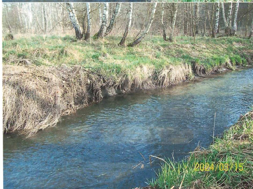
Awaryjne usunięcie tam bobrowych i zatorów z koryta rzeki Leśnica przy ul. Łużyckiej w m. Wodzisław Śląski.
