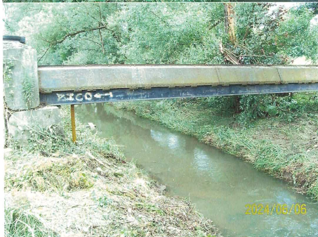
Usunięcie zatoru z koryta rzeki Bobrówki w m. Cieszyn.
