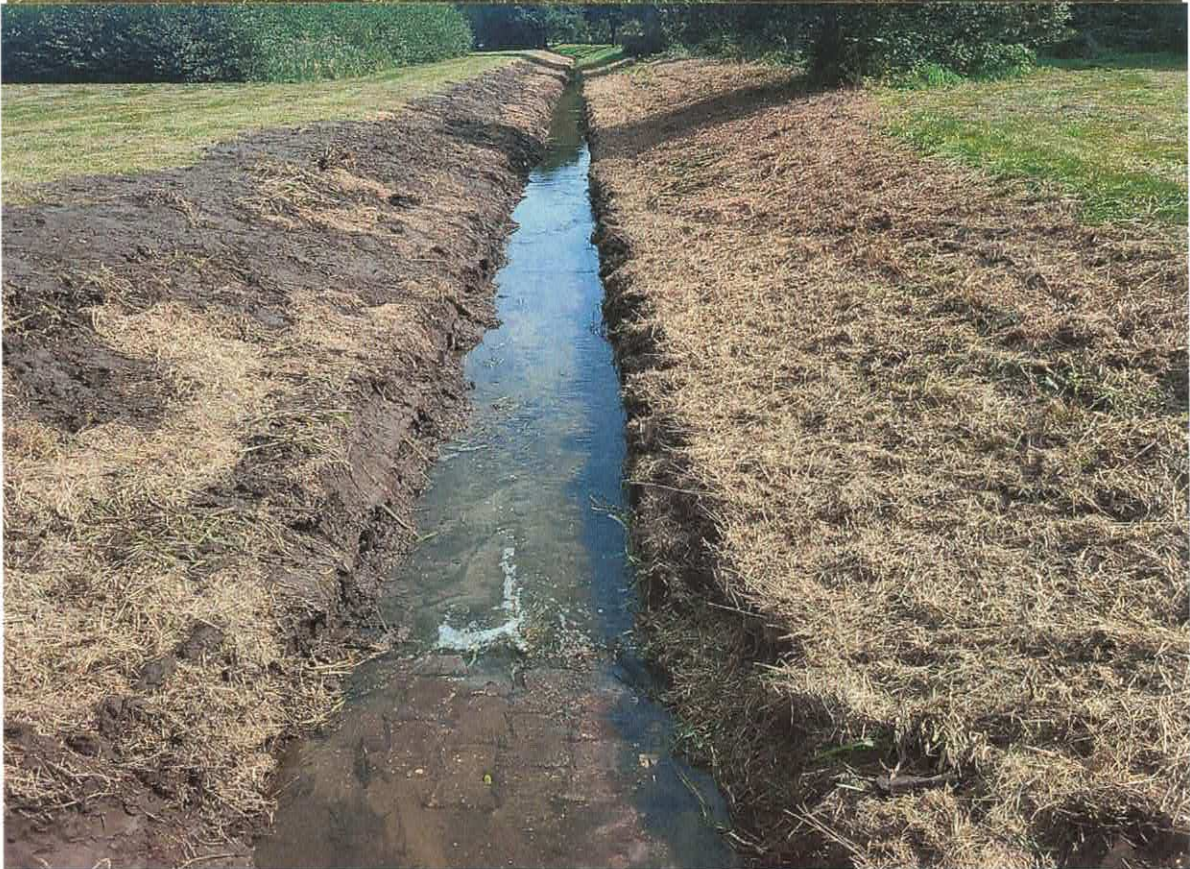
Odcinkowa konserwacja cieku Mszanka w km 0+000 – 4+000.
