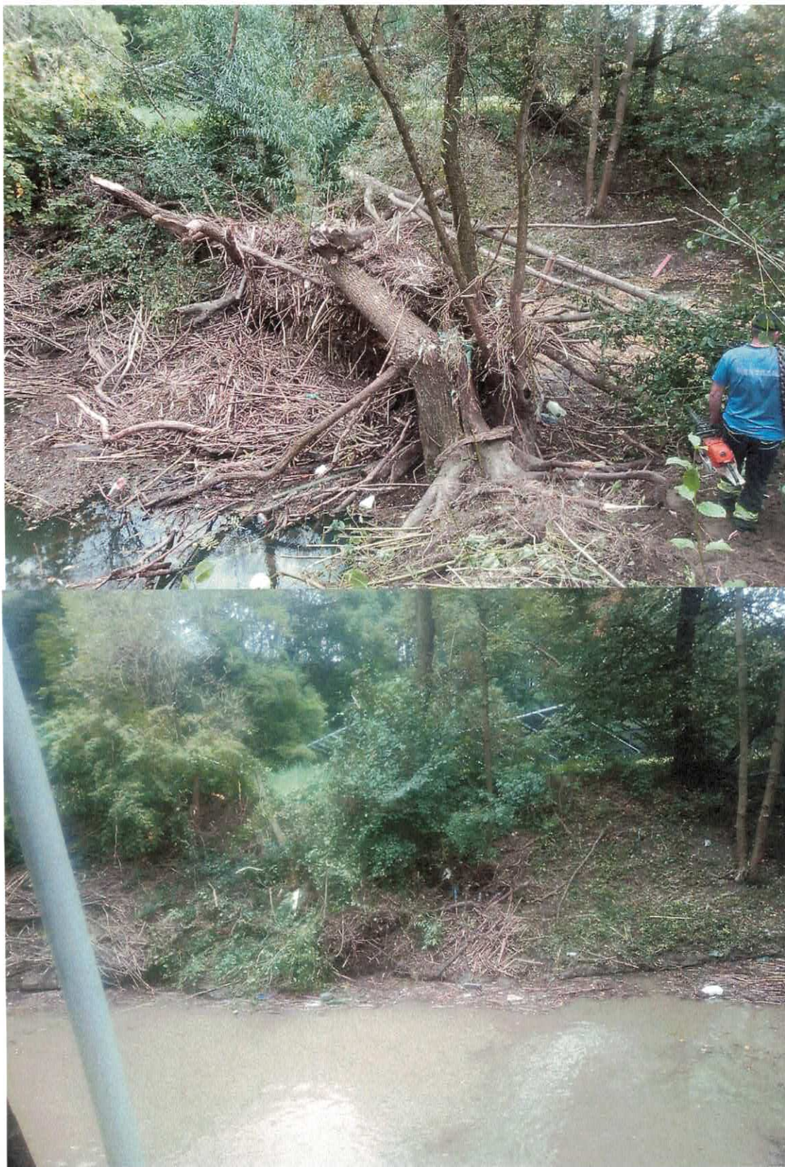
Awaryjne usunięcie zatoru na rzece Bobrówce w km 0+780 w m. Cieszyn.
