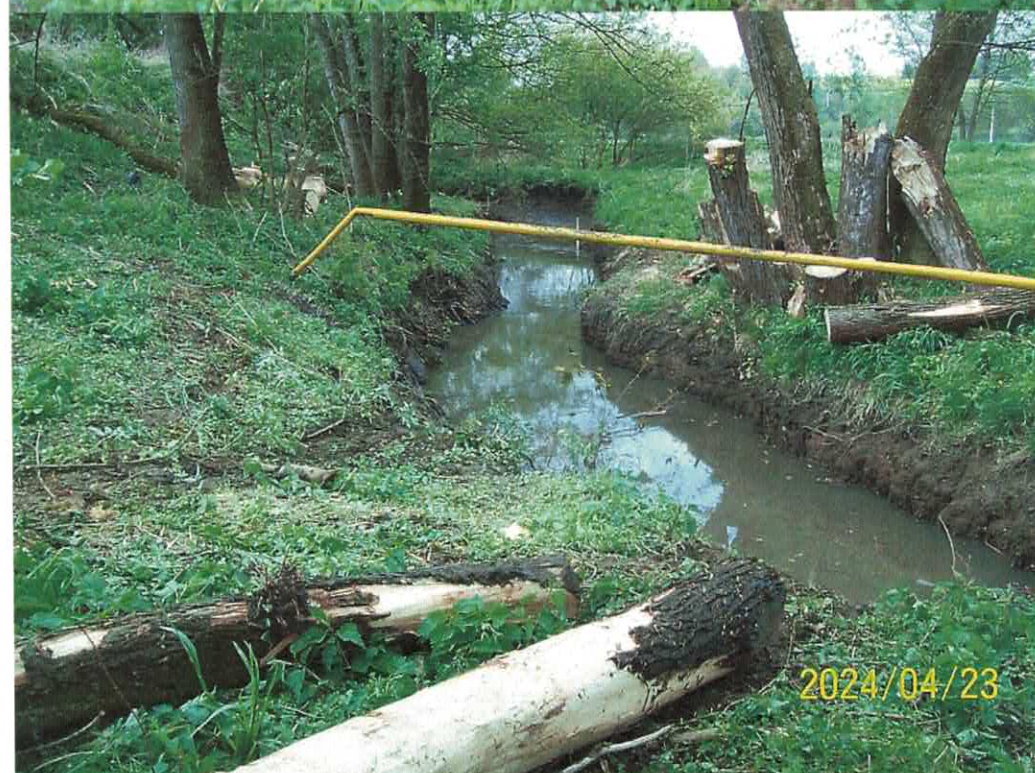
Usunięcie zatoru z koryta rzeki Bielowiec w okolicy ul. Braci Miłosiernych w Cieszynie.
