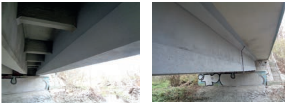
Zdjęcie nr 70 i 71 . Naprawiony element konstrukcyjny mostu w ciągu ul. Bielskiej w Cieszynie
