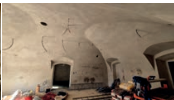
Zdjęcie nr 7. Planowana kawiarnia na parterze
