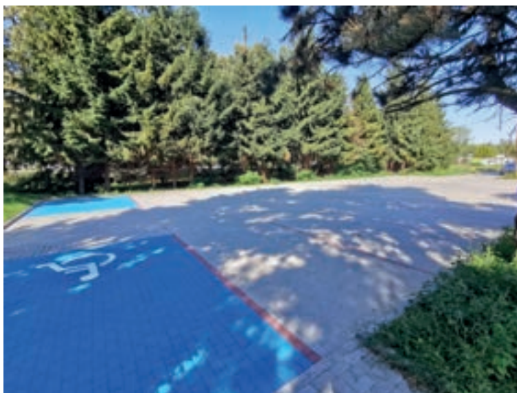
Zdjęcie nr 50. Zmodernizowany parking
