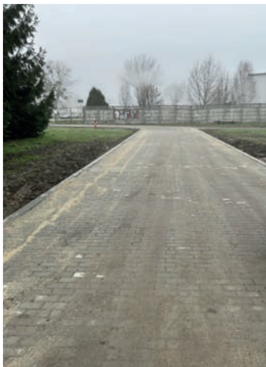
Zdjęcie nr 51. Wyremontowana droga wewnętrzna
