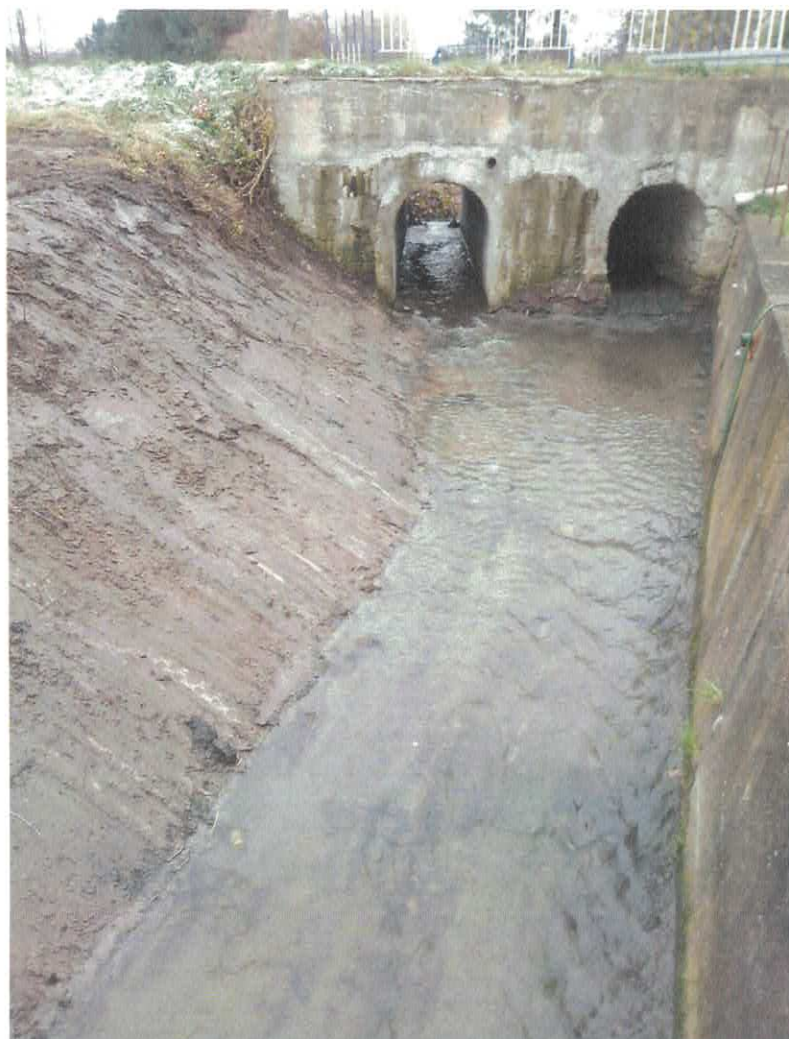
Prace utrzymaniowe koryta cieku Skotniczanka przed i po.
