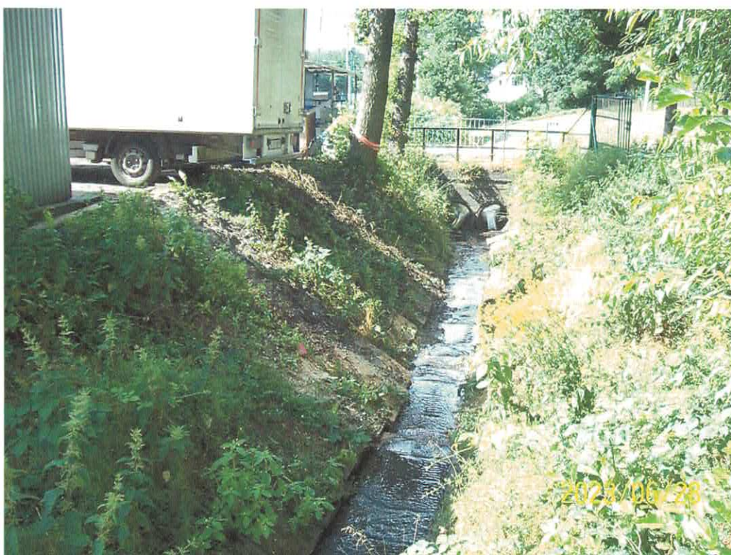
Usunięcie zatoru z koryta cieku Jastrzębianka przed i po.
