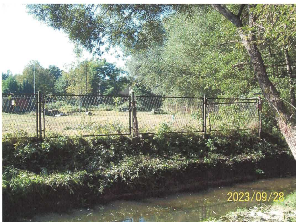
Usunięcie wiatrołomu z ciek Jastrzębianki przed i po usunięciu.
