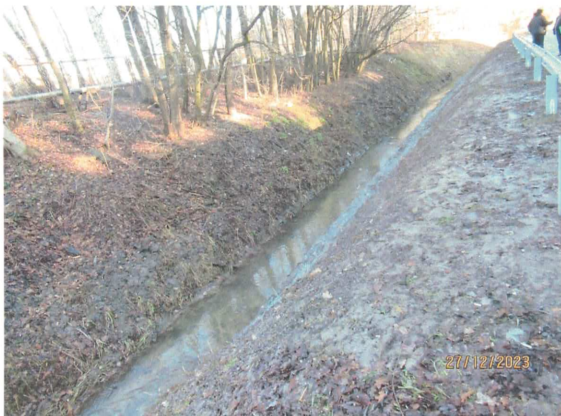
Prace utrzymaniowe na cieku Marklówka przed i po wykonaniu.
