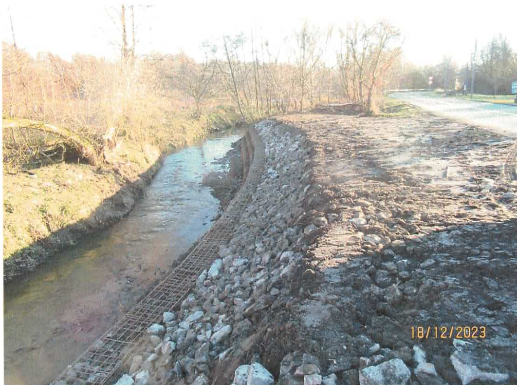
Zabudowa wyrwy w prawym brzegu rzeki Leśnicy przed i po wykonaniu.
