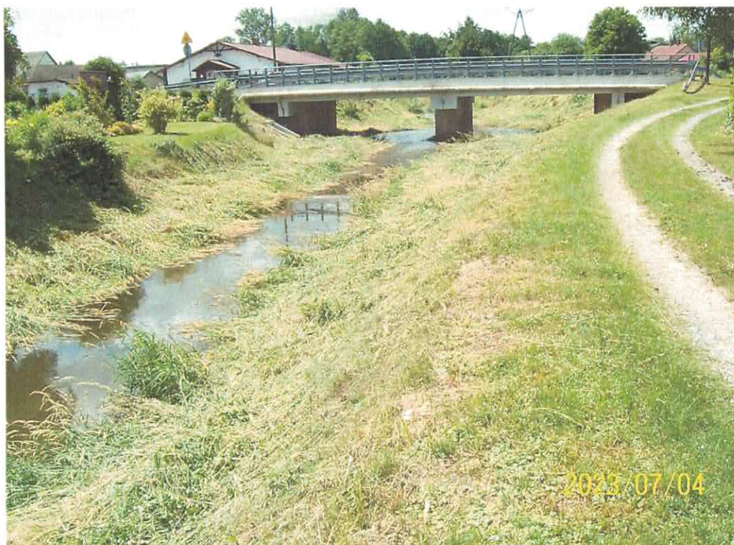
Wykoszenie skarp rzeki Szotkówki przed i po wykonaniu.
