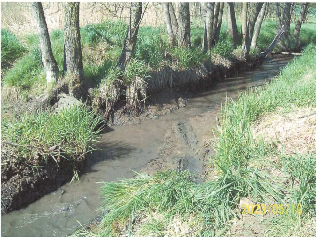
Przykład usunięcie zatorów z koryta cieku Kucharzówka przed i po.
