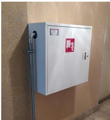
Zdjęcie 63,64. Instalacji hydrantowa w ZS im. Szybińskiego w Cieszynie
