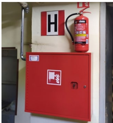
Zdjęcie 63,64. Instalacji hydrantowa w ZS im. Szybińskiego w Cieszynie
