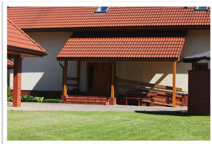
8. WEJŚCIE DO ŚWIETLICY
