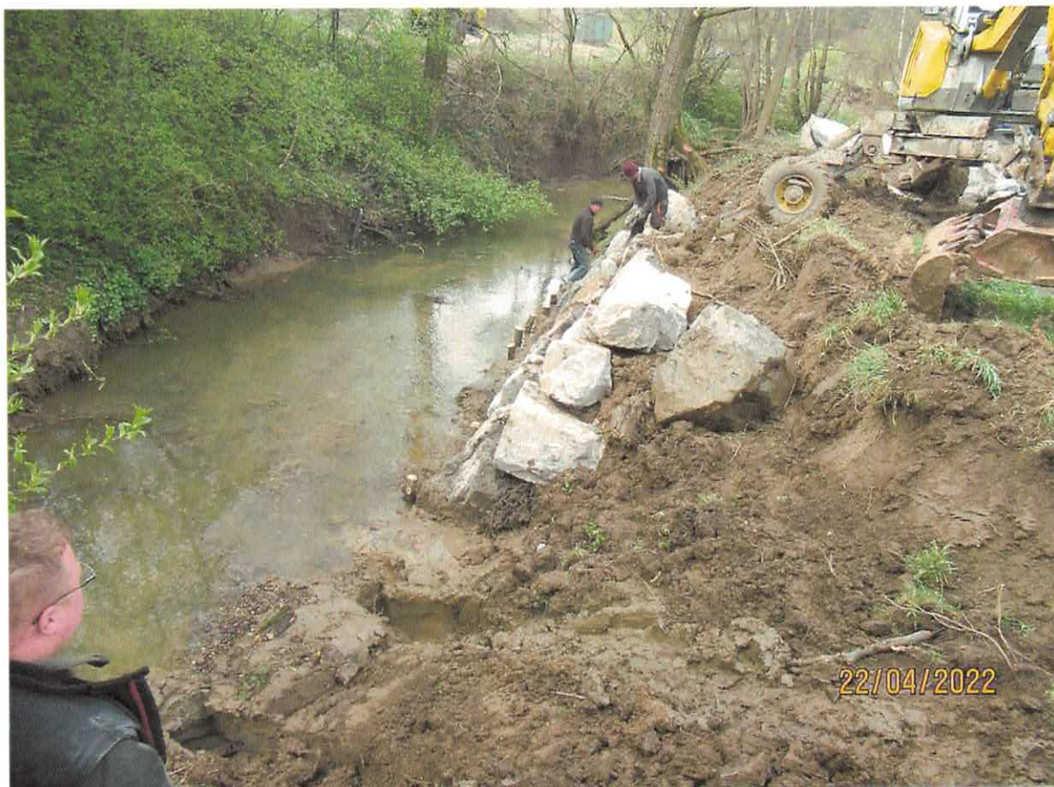
Piotrówka w Kończycach Wielkich zabudowa wyrwy - przed konserwacją i w trakcie
