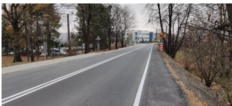
Zdjęcie 7 Droga powiatowa - ul. Górecka w Skoczowie po przebudowie
