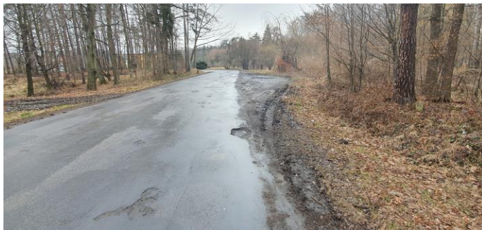
Zdjęcie 8 Droga powiatowa -ul. Tuwima i ul. Korczaka przed przebudową
