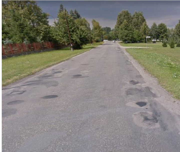
Zdjęcie 3 Droga powiatowa - ul. Górecka w Skoczowie przed przebudową
