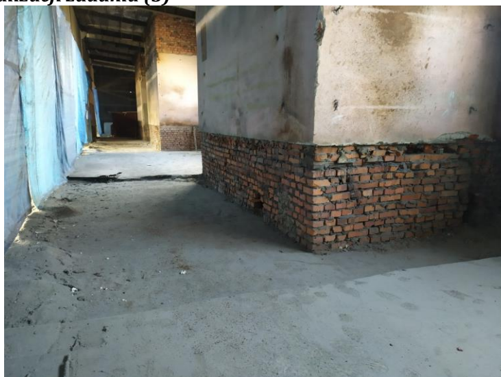
Zdjęcie 12 Stan po realizacji zadania (3)
