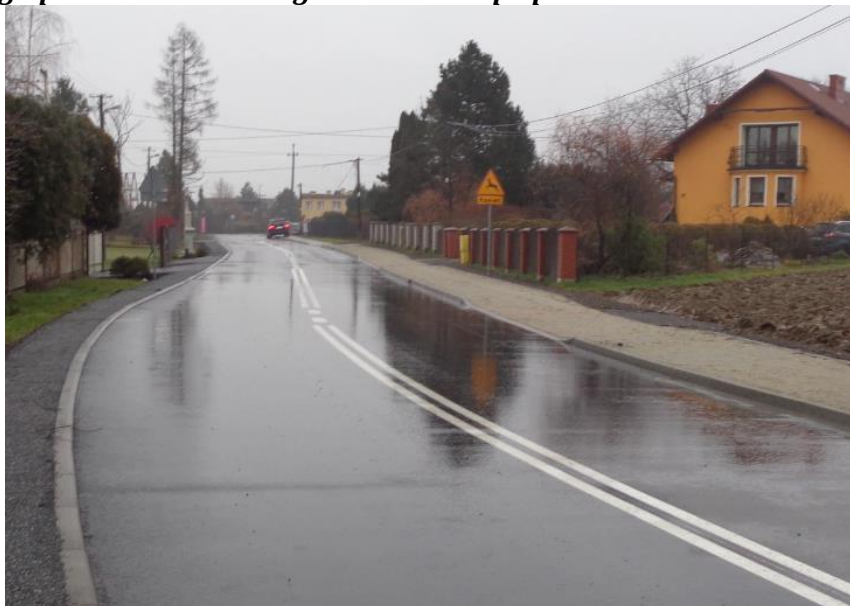
Zdjęcie 6 Droga powiatowa - ul. Długa w Hażlachu po przebudowie
