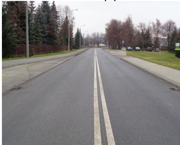
Zdjęcie 4 Droga powiatowa - ul. Górecka w Skoczowie po przebudowie
